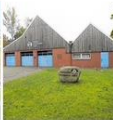
Das Gebäude in Lahn wird erweitert und komplett umgebaut. Foto: R. Hagemann
