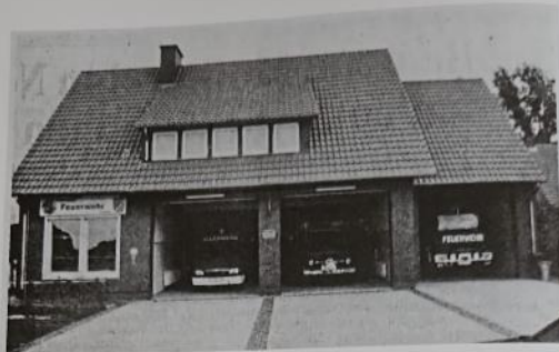
Feuerwehrhaus nach Ausbau und Erweiterung.
