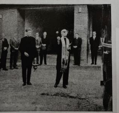
PFARRER UTHOFF bei der Weihe des Gerätehauses und des Löschfahrzeuges.
