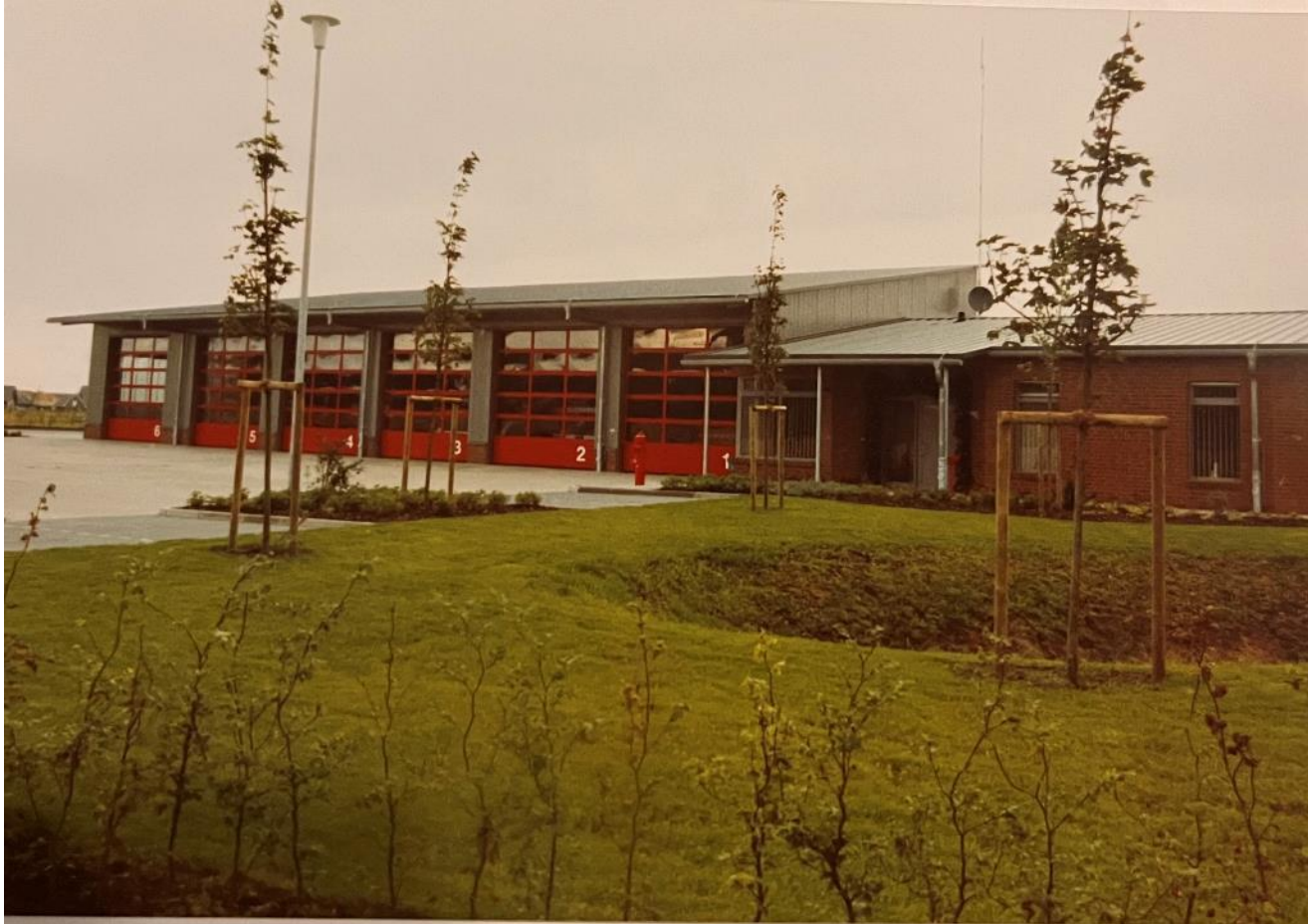
2004: FF Dörpen neues Feuerwehrhaus
